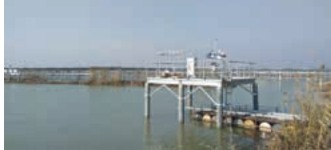
江苏泗洪某光伏发电项目配套气象站
