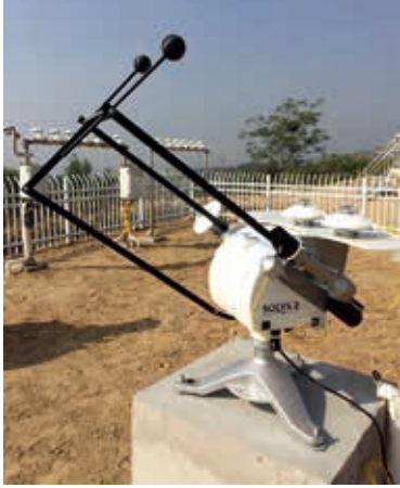
山西芮城某光伏发电项目配套气象站
