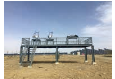
青海共和某光伏发电实证基地
